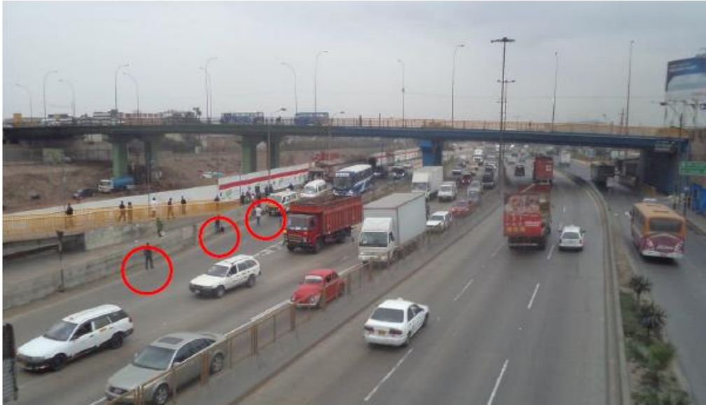
Vía Evitamiento: Paradero Rayitos de Sol (altura Puente Santa Rosa), peatones en vía con alto fluido vehicular a alta velocidad.
